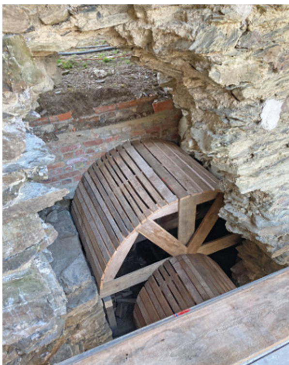
links: Ausbau des Ausfalltors
