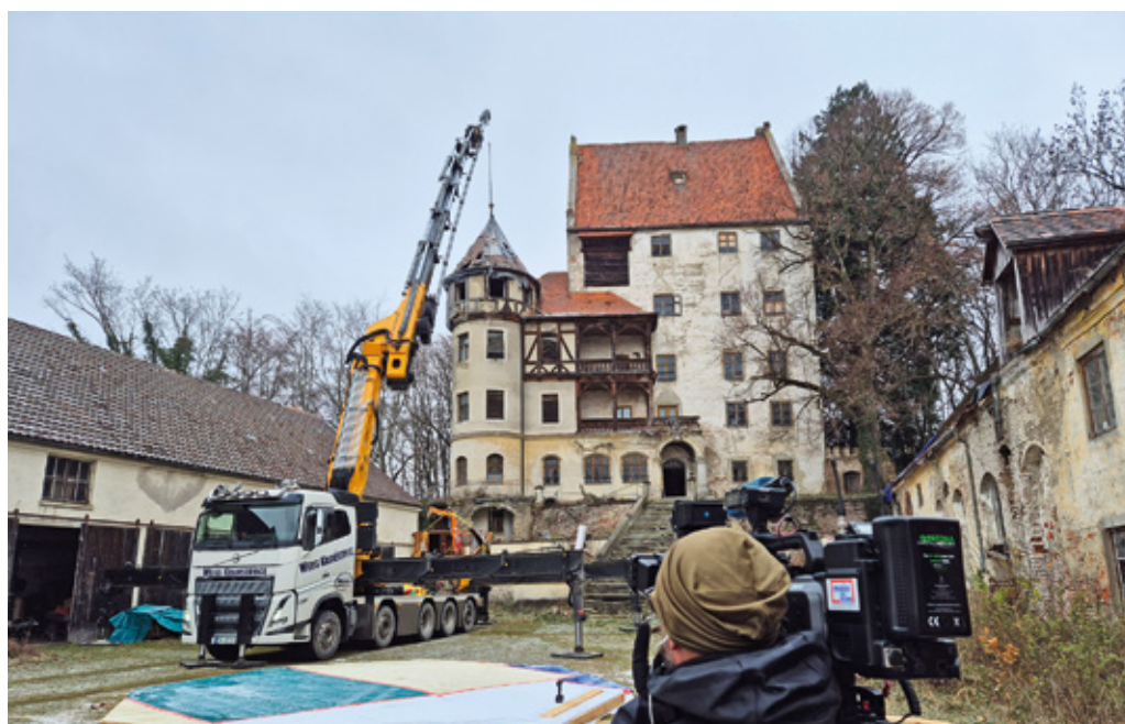
Sanierungsarbeiten am Schloss Mattsies © Iris Tsakiridis
